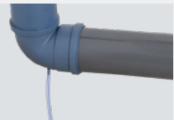
Kondensatablauf mit Rückschlagventil
